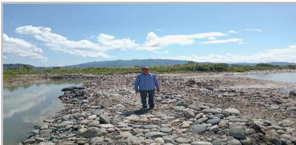
FOTO N°03: TRAMO CONFORMACIÓN DE DIQUE CON ENROCAMIENTO PARA PROTECCIÓN DE INFRAESTRUCTURA DE RIEGO Y ÁREAS AGRÍCOLAS.
